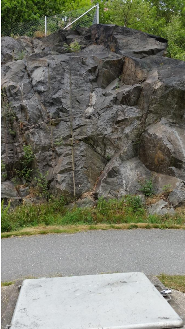
Figur 5. Ungefärligt läge för borrhåslag. Spillvattenpumpstation, från vilken borrhåll planeras, observeras i förgrunden.
