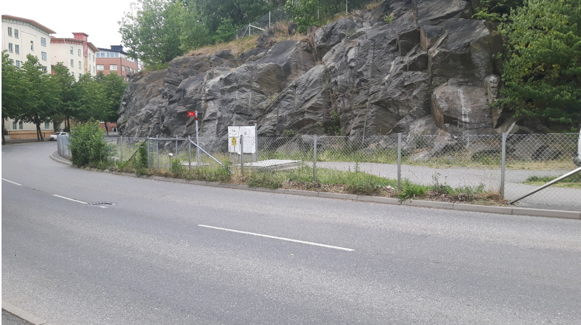
Figur 1. Befintlig spillvattenpumpstation vid Östra Eriksbergsgatan
